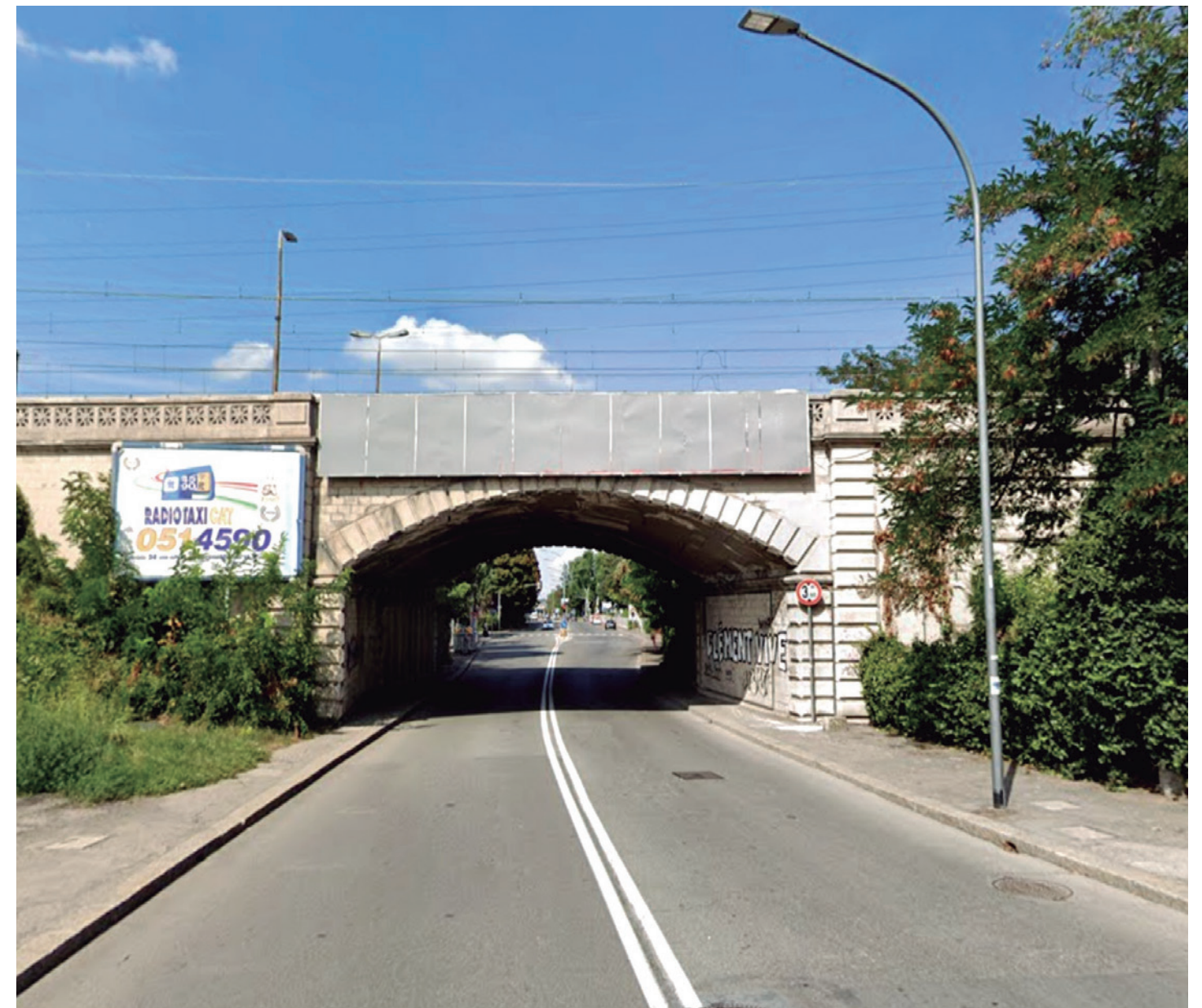
Immagine del sottopasso della ferrovia - stato attuale
