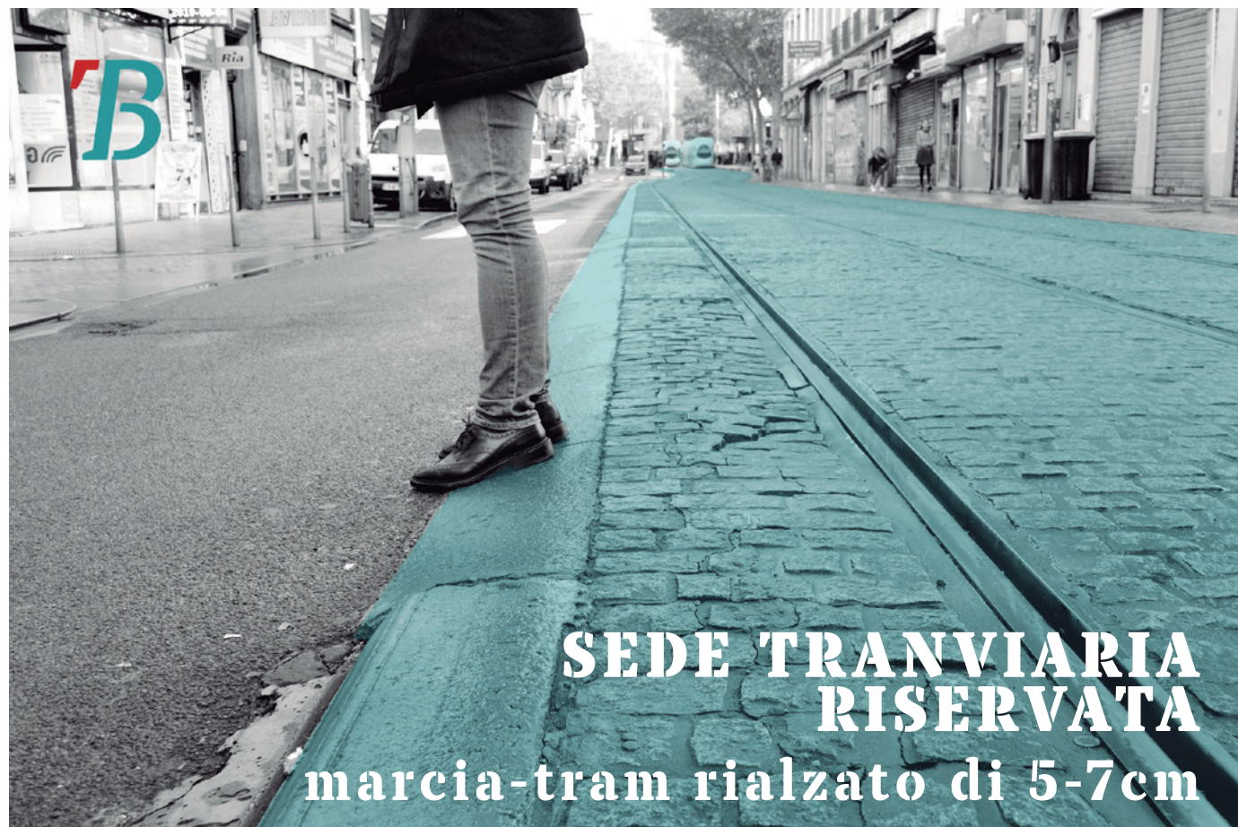
Fotografia della sede riservata della tranvia di Lione ©archivio FIU
