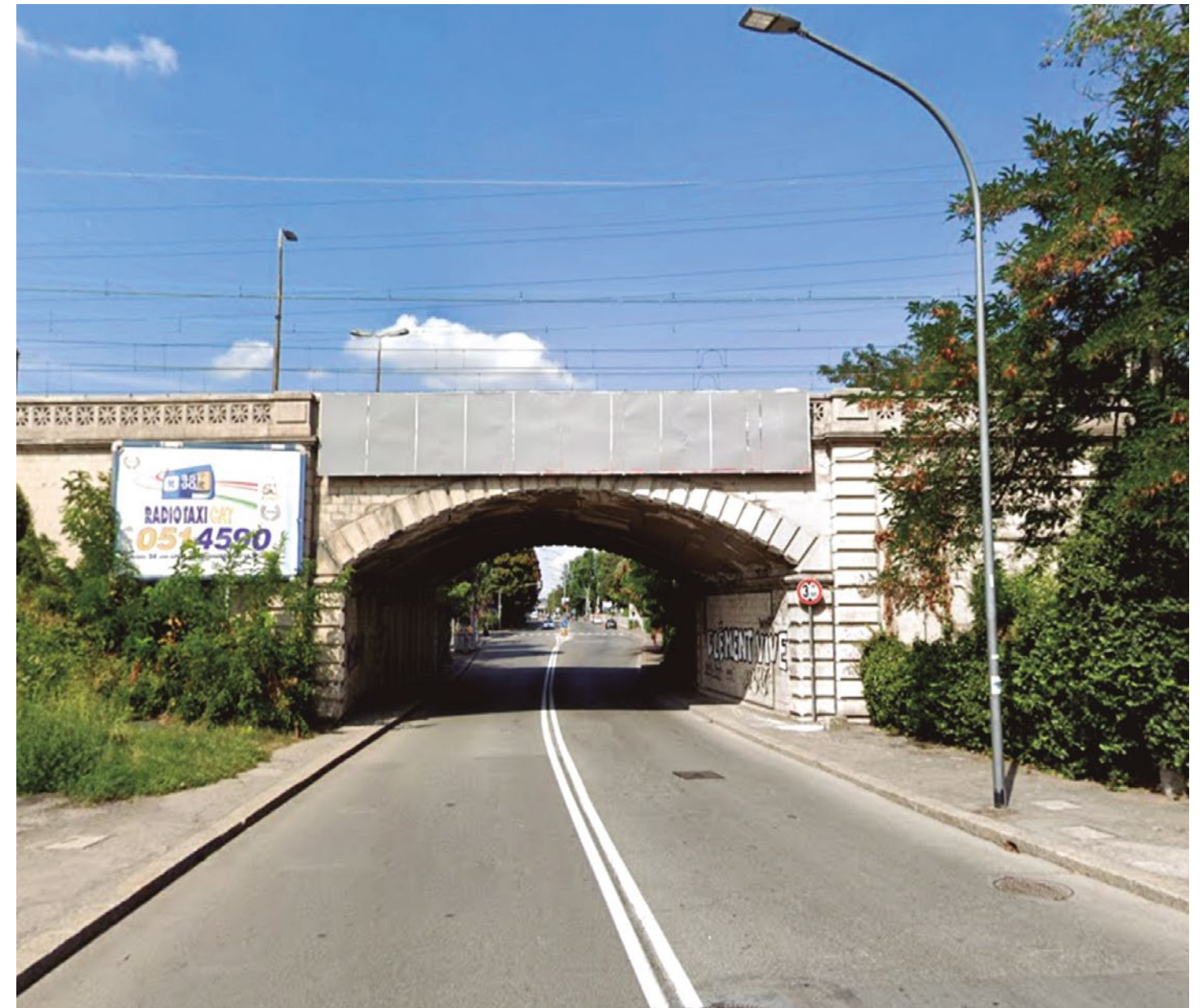
Immagine del sottopasso della ferrovia - stato attuale
