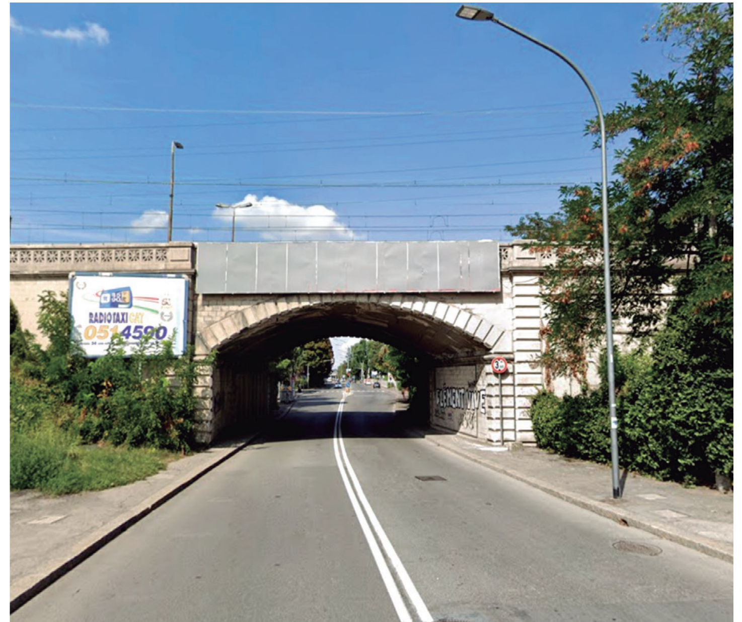
Immagine del sottopasso della ferrovia - stato attuale
